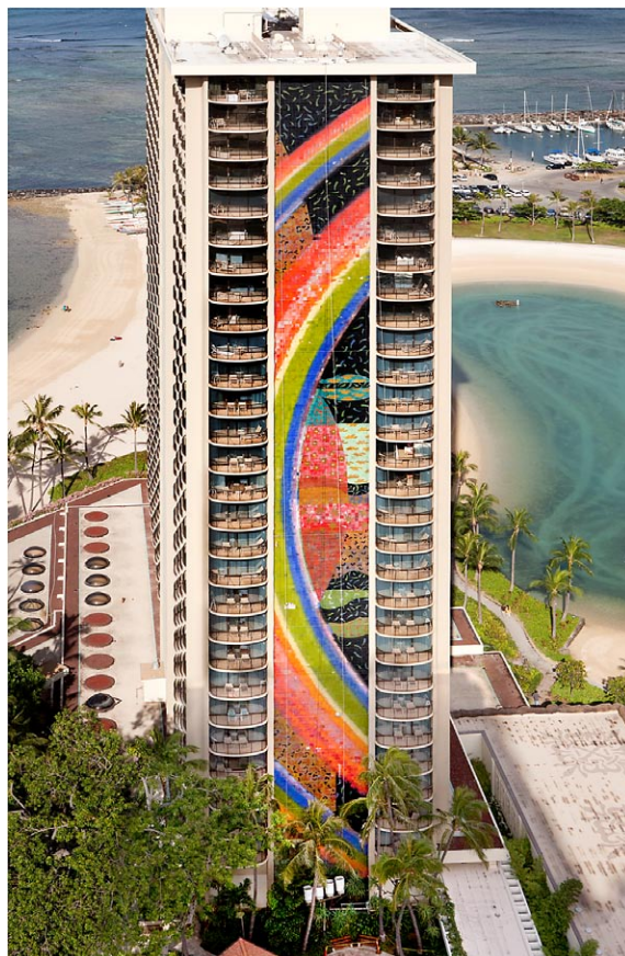
Figura 8 – Fachada cerámica de 30 plantas antes de la sustitución
