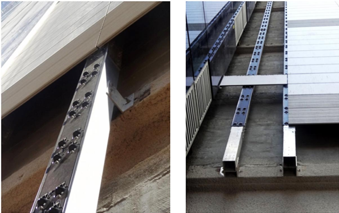
Figura 11. Instalación del sistema de fachada ventilada: perfil del tubo vertical conectado a la estructura del edificio por ángulos y pernos de acero inoxidable. Los rieles sujetos al perfil se encargan de la sujeción de los paneles de cerámica.
