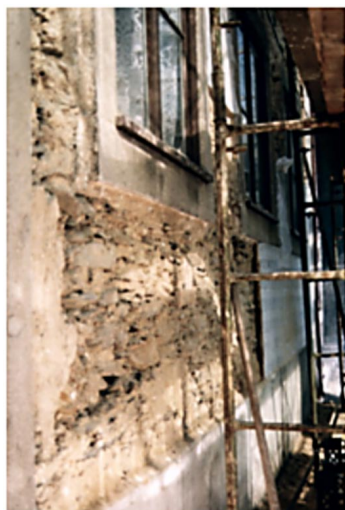
Fig. 3 – Remoción de los azulejos desprendidos durante la intervención.
