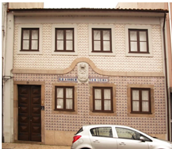
Fig. 4 – Aspecto actual de la fachada.
