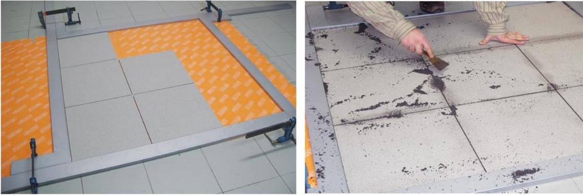
Figura 8. Realización del prototipo del sistema por adhesivo pulverulento
