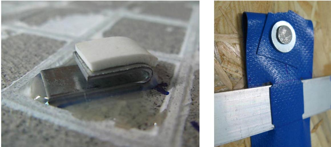
Figura 12. Detalles del sistema: Gancho pegado, cinta y listón
