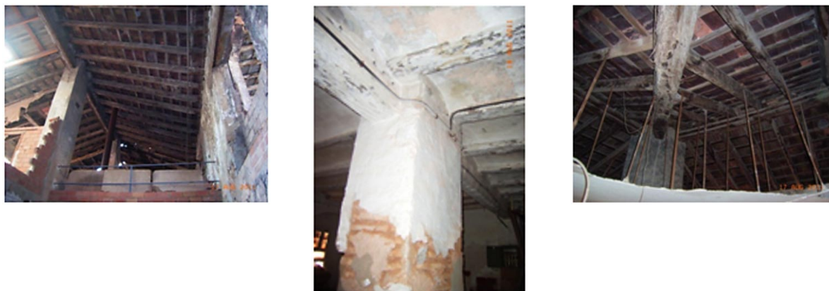
Fotos de elementos estructurales interiores.
