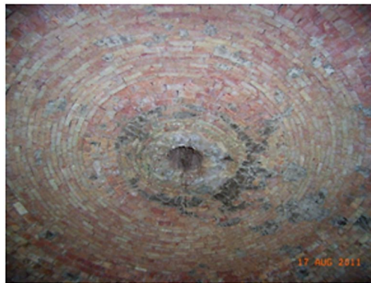
Foto de la bóveda de horno existente.
