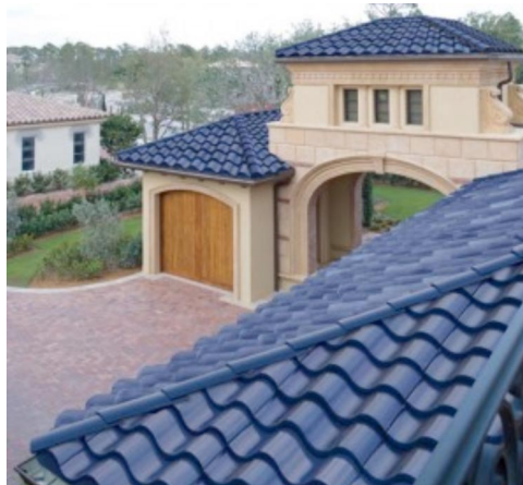
Figura 11. Baldosas fotovoltaicas instaladas junto con baldosas tradicionales de arcilla. Fuente: SRS Energía 3 .
