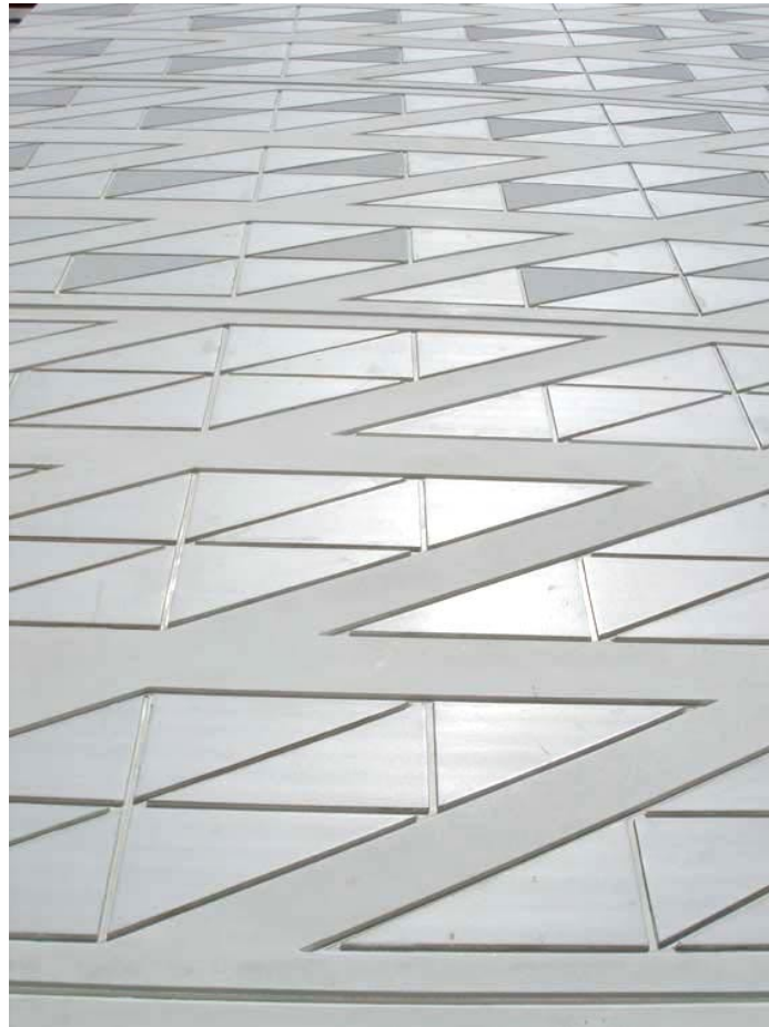
Figura 11. Fotografía de la cubierta instalada.
