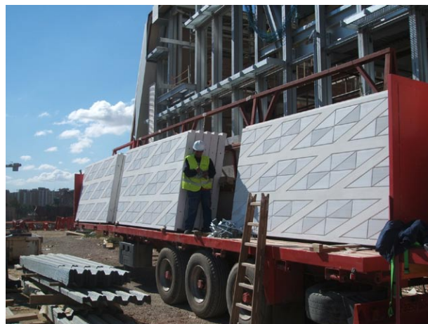
Figura 12. Transporte de los paneles para su instalación.
