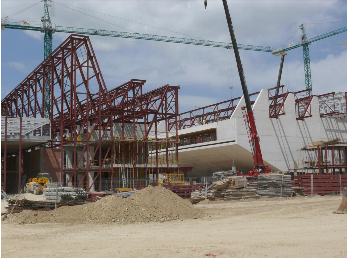
Figura 3. Estructura de hierro de la cubierta sin paneles de GRC.
