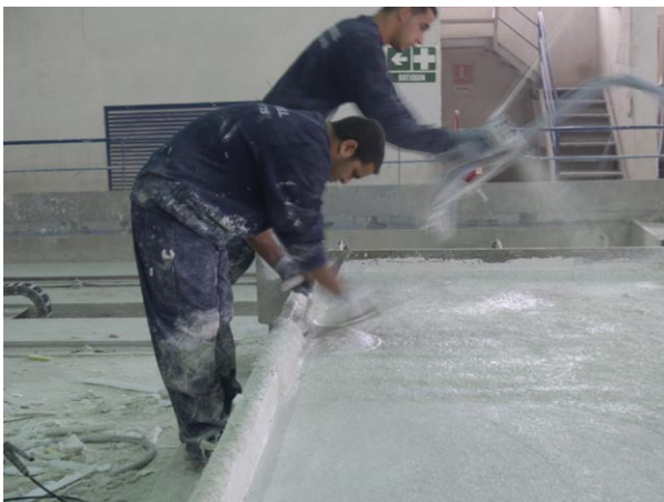
Figura 9. Proyección del cemento en los paneles.
