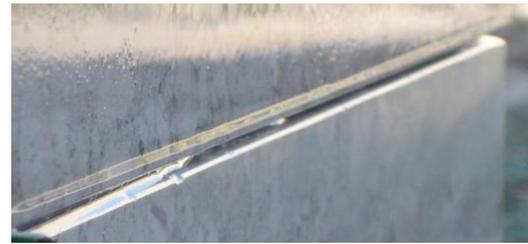
**Entrada directa por viento:** la energía cinética del viento en caso de la lluvia provoca la caída del agua con una vierta inclinación que puede llegar a entrar en las juntas de las placas. Este fenómeno es aún más acusado en las juntas verticales.
