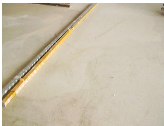
Figura 4. Base de mortero terminado y fraguado.
