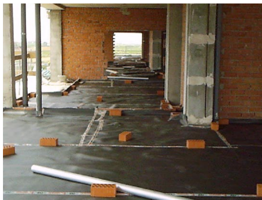
Figura 1. Colocación lámina para aislamiento acústico.
