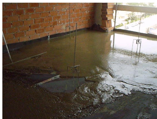
Figura 3. Vertido del mortero autonivelante.
