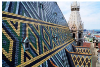
Figura 3. Volumen de la cubierta sobre la fachada pétrea. Catedral de San Esteban, Viena.
