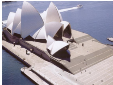
Figura 23. Vista de las velas sobre el basamento pétreo. Ópera de Sydney, Australia, Jørn Utzon.
