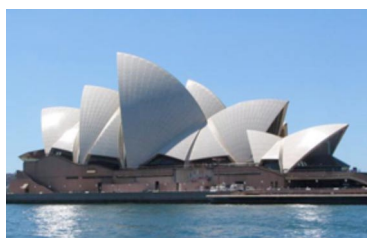
Figura 21. Vista general de la Ópera de Sydney, Australia Jørn Utzon.
