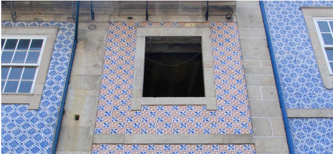
Figura 5. Barcelos, varias fachadas urbanas contiguas, en el centro de la ciudad, con revestimiento de azulejos desde c. 1860-1880: un ejemplo de similitud con el papel para tapizar.
