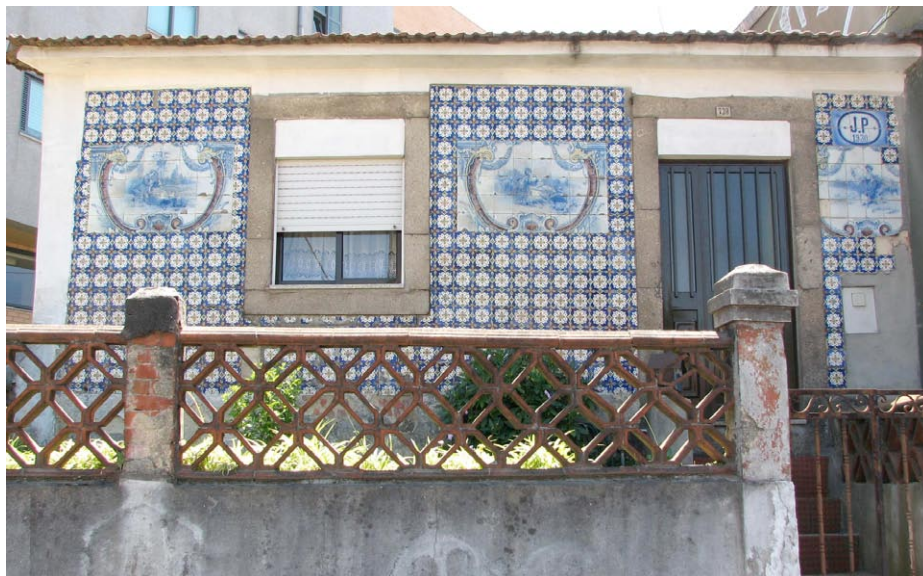
Figura 9. Vila Nova de Gaia, uno de los últimos ejemplos de fachadas cubiertas con azulejos (1930). Este ejemplo no constituye una norma y representa el final de la línea de este fenómeno artístico, en una época donde únicamente las clases populares, especialmente aquellas que vivían cerca de las fábricas de cerámicas (como este caso), preferían decorar las fachadas de sus modestas casas con azulejos cuyos diseños ya se utilizaban hacía décadas, así como también con otros elementos cerámicos.
