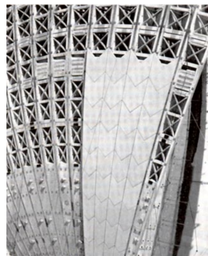
Figura 16. Revestimiento en construcción.
