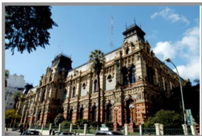
1. Palacio de las Aguas.
