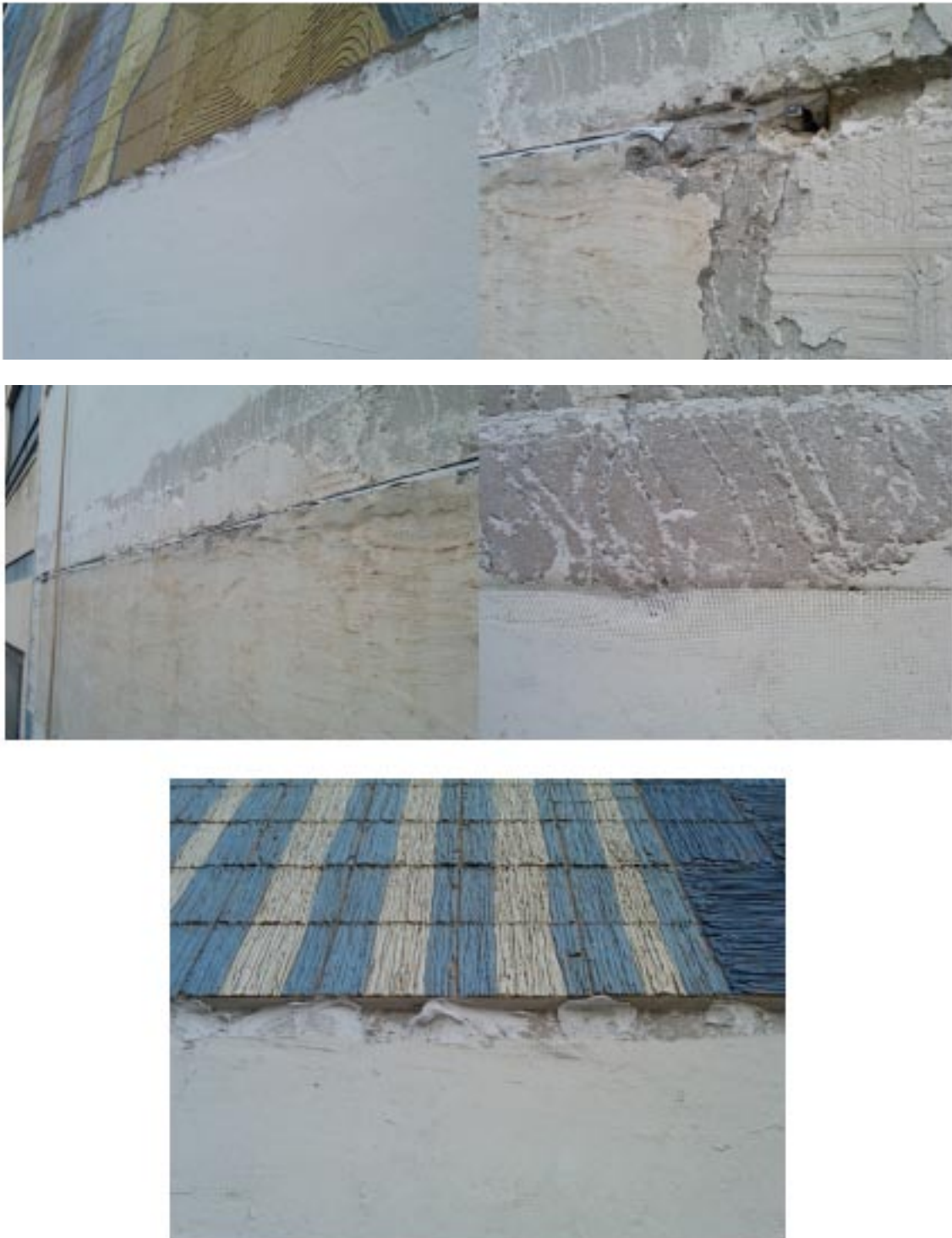
Figura 19. Estado previo del soporte y proceso de reparación.
