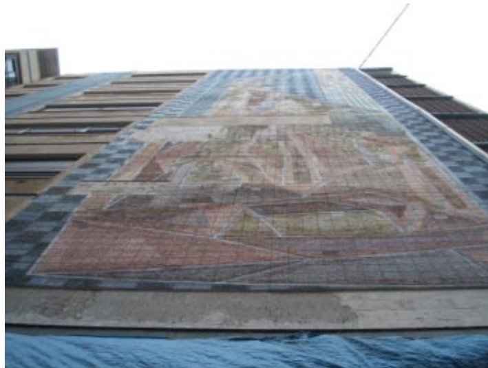
Figura 13. Inicio de la restauración, de abajo a arriba para evitar desprendimientos.
