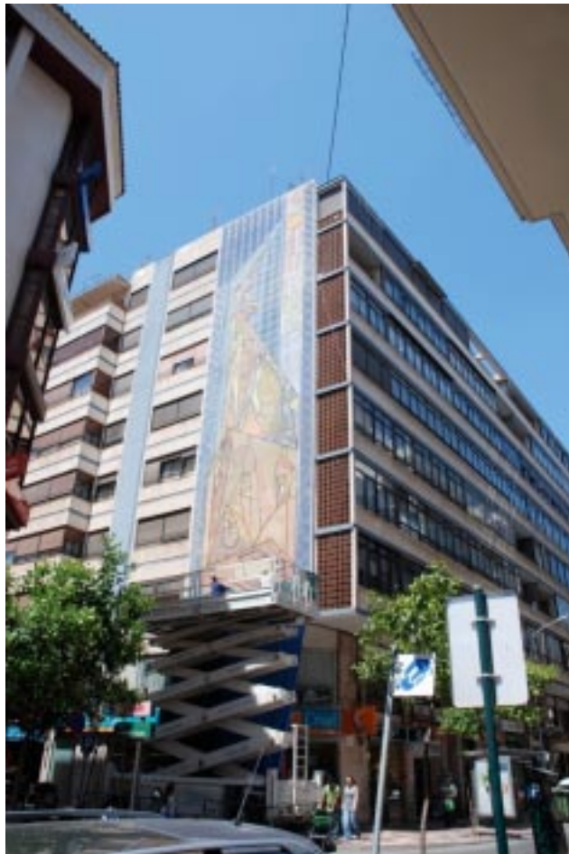
Figura 2. Vista actual del edificio.
