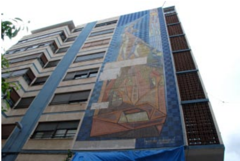
Figura 15. Inicio de la restauración. Retirada de las piezas de abajo a arriba.
