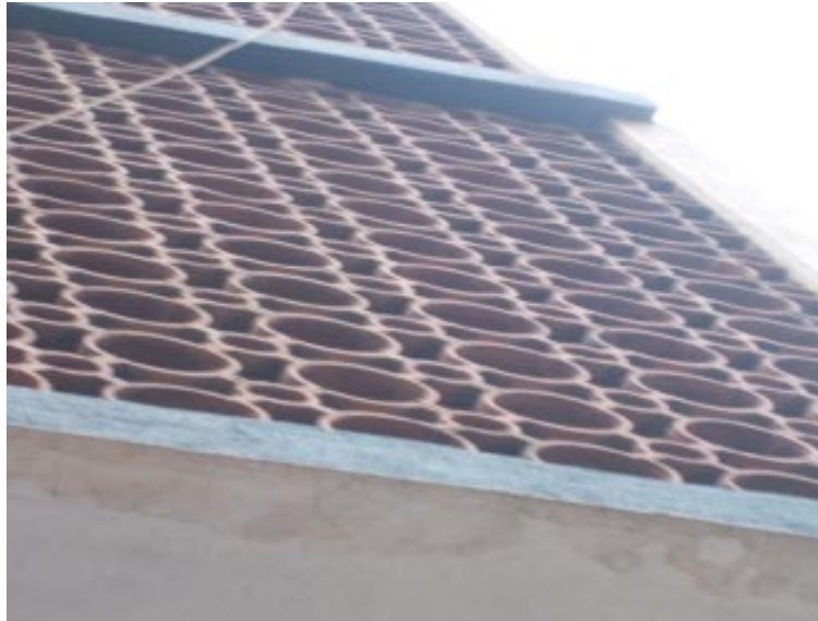
Figura 3. Celosía cerámica exterior de "la Fábrica de Agustinet".
