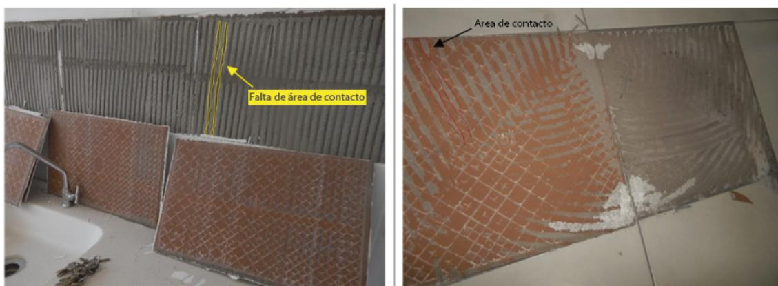
**Figura 4** – Superficie real de la baldosa desprendida, que revela la reducción efectiva del área de contacto causada por un procedimiento de fraguado deficiente [27].
