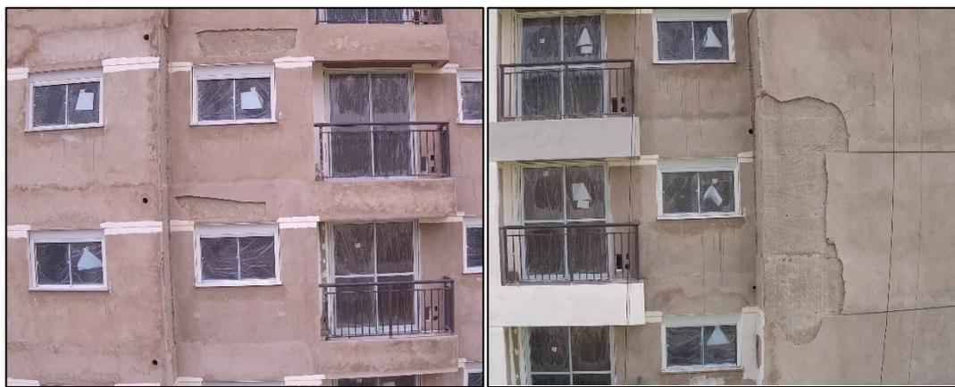
**Figura 3** – Manifestación patológica de desprendimientos en las interfases del recubrimiento con la superficie del hormigón, incluso durante la fase de ejecución del sistema de recubrimiento adherido.
