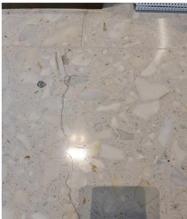
**Fotografía 1** – Fisuras en una baldosa de cuarzo en una junta fría de un centro comercial.
