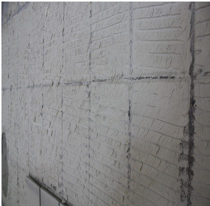
**Fotografía 5** - Muestra evidencia de las fuerzas de cizallamiento sobre el adhesivo de las baldosas dentro de una piscina donde se ha producido un fallo.
