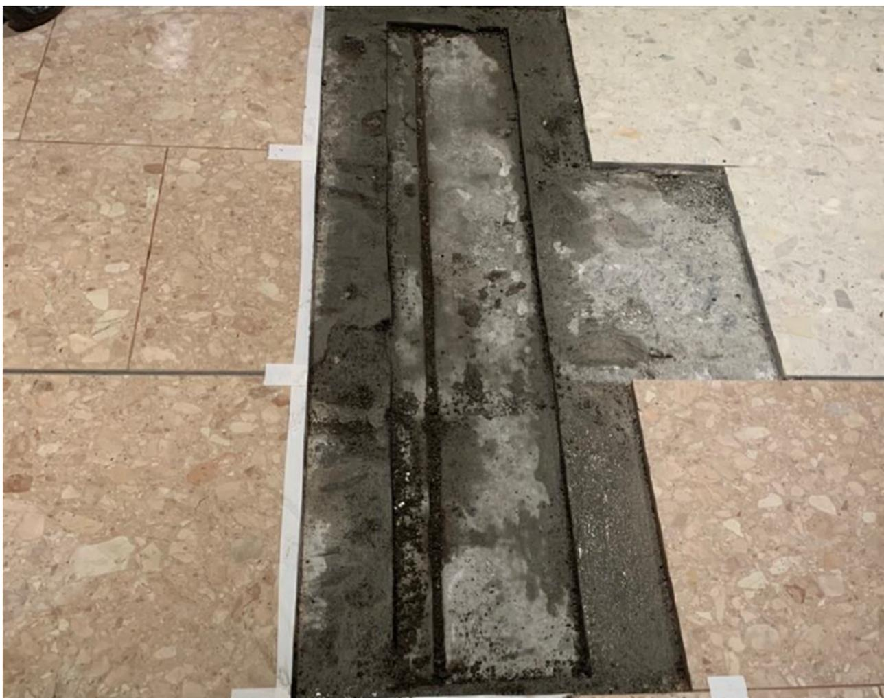
**Fotografía 2** - Junta entre losas de un centro comercial en la que el sistema de aislamiento de fisuras no consiguió evitar la formación de fisuras donde el arquitecto prescribió que no hacía falta juntas entre las baldosas.
