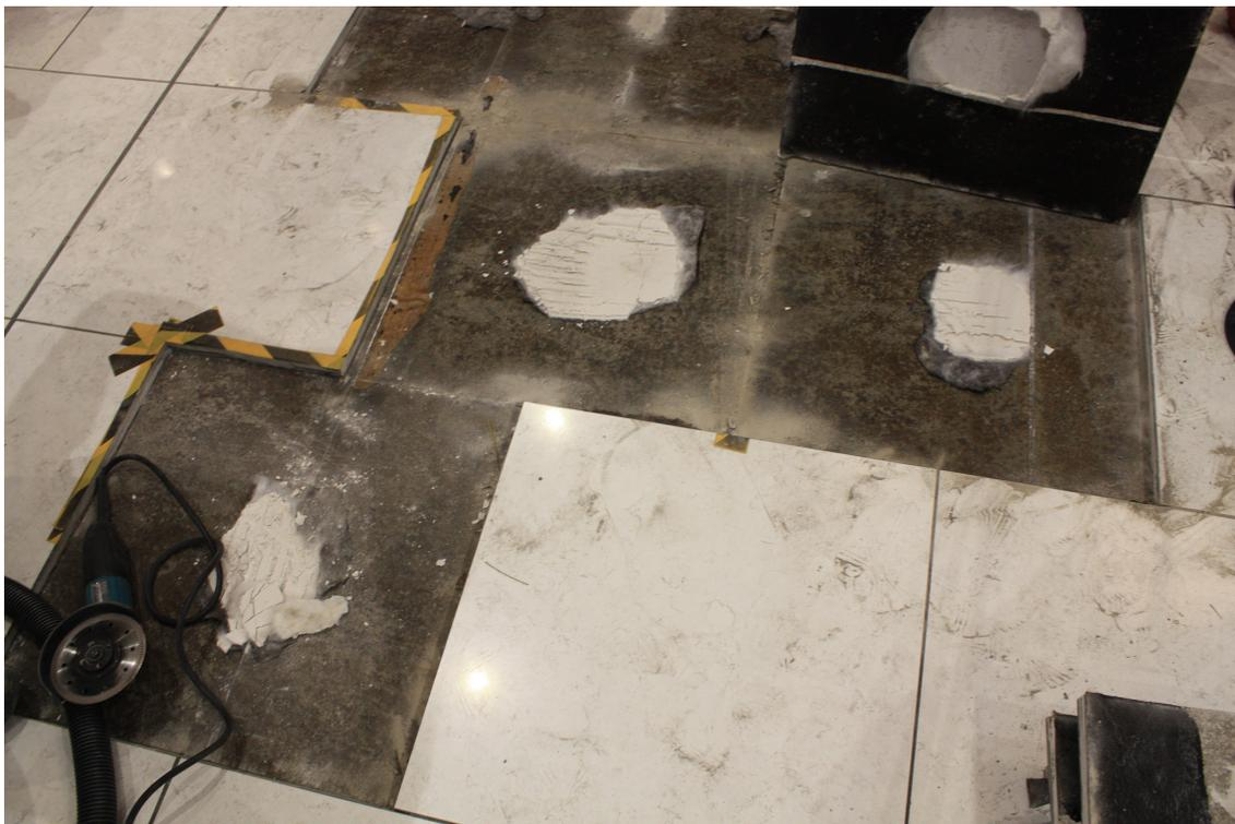
**Fotografía 4** - Baldosas de piedra artificial instaladas sobre una malla anti-fisuras que posteriormente presentan alabeo y se desprenden parcialmente.
