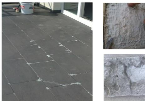
**Figura 5.** Efectos de la hidrólisis alcalina en un pavimento cerámico
