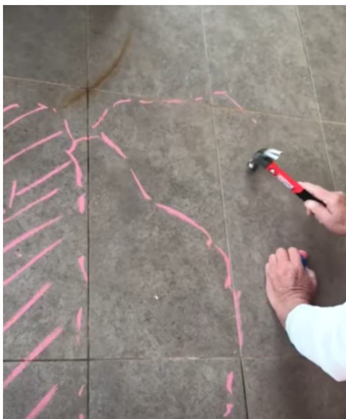
Figura 1. Aquí se utiliza un pequeño martillo y tiza para delimitar la zona de sonido hueco.
