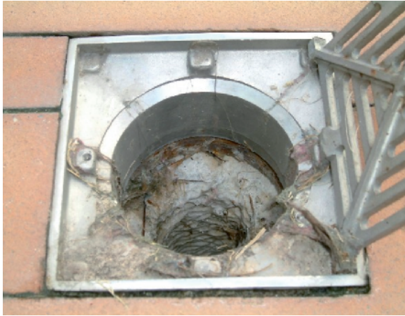
Foto 5. Cuando el desagüe está abierto en su cuello, y hay una pendiente del sustrato al desagüe las eflorescencias se forman a lo largo del tubo de desagüe y no sobre las baldosas.
