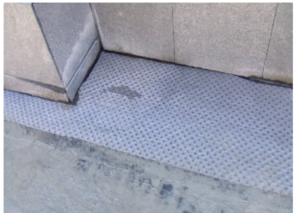
Foto 8. El tejido celular de drenaje bajo la solera de nivelación facilita dirigir el agua subterránea a las salidas designadas.
