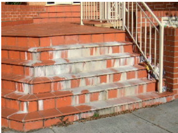
Foto 1. Un ejemplo de eflorescencia secundaria con la formación de carbonato cálcico en la superficie de un recubrimiento de escalera en exterior.
