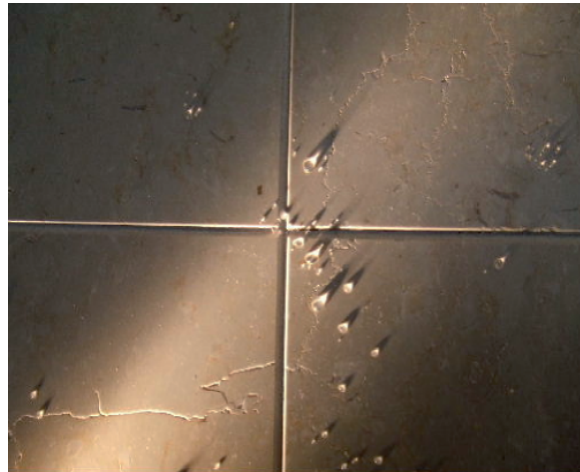
Foto 4. La aplicación de un sellante penetrante evita o minimiza la penetración de agua a través de las baldosas y el rejuntado
