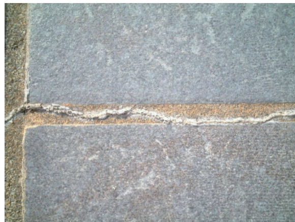
Foto 2. Formación de eflorescencia donde la humedad sube desde debajo de las baldosas impermeables a través de grietas en el material de rejuntonado.
