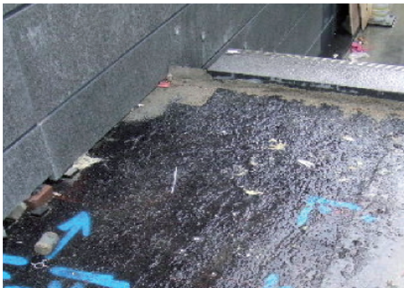
Foto 7. Una alcantarilla bajo el lateral izquierdo de las escaleras que contiene material celular de drenaje bajo la baldosa, llevará el agua que llega del rellano y evitará que emerja a través de las contrahuellas de escalera
