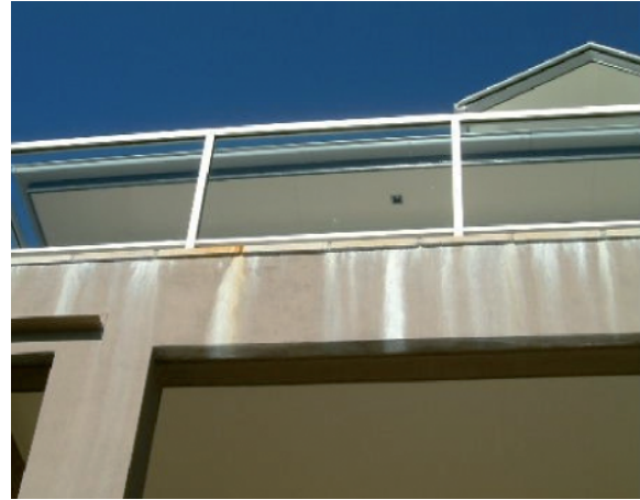
Foto 6. Allí donde la pendiente en el sustrato lleva a un borde libre, se formará eflorescencia en las contrahuellas de escalera. Para evitar este problema tenga un ángulo que pare el agua sellado al suelo en el borde o a 1 baldosa detrás del borde, y tenga el sustrato tras el ángulo inclinado hacia un desagüe.
